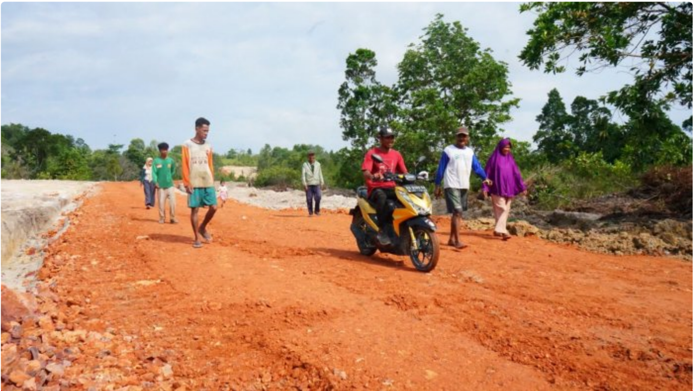
Pembukaan Jalan Rampung 100 Persen, Warga Berbondong-Bondong Datang Ke Lokasi
